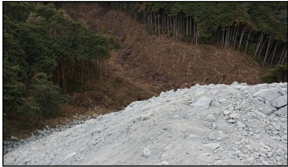
健幸の森公園の谷に捨てられた土砂
